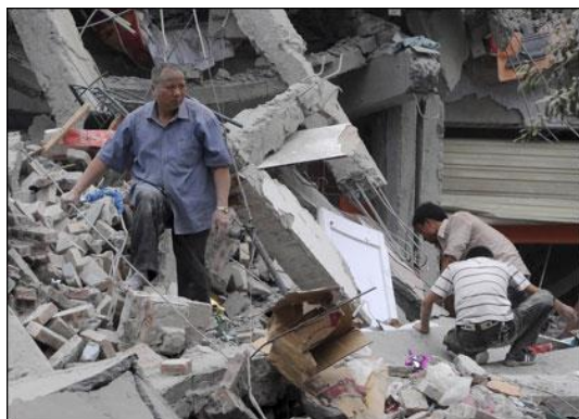
都江堰市聚源中學發生教學樓垮塌，眾多學生被埋。
